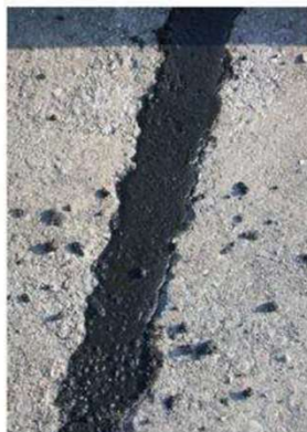
Materiale subito dopo il riempimento
