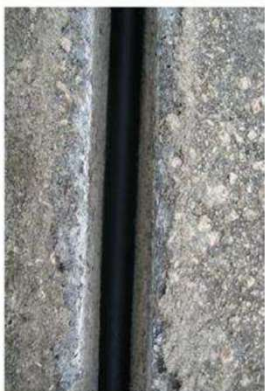
Scavo aperto con tubazione posata
