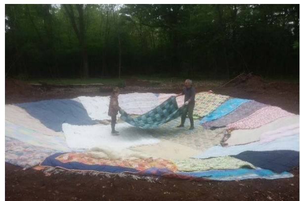
Figure 10 e 11. Lo scavo ed il modellamento dello stagno. Posa di coperte usate (recuperate gratis grazie a un annuncio su Facebook) per proteggere la posa successiva del telo impermeabile (foto A.Longo).
