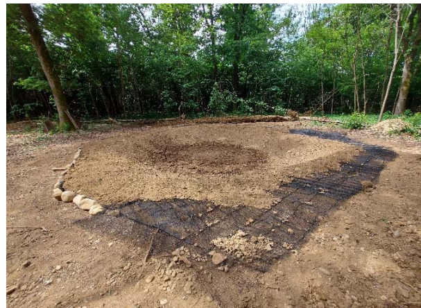
Figure 12 e 13. La posa del telo impermeabile e della rete plastificata per favorire la tenuta di terriccio (foto A.Longo).
