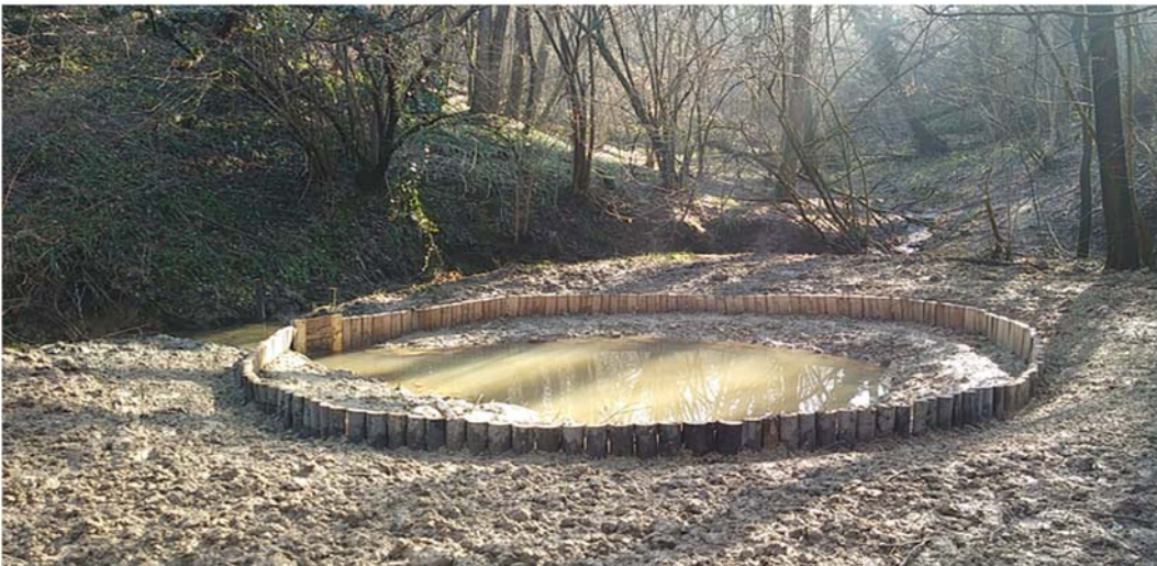
Figura 18. (sopra) barriera antigambero realizzata intorno alla Sorgiva del Giardino delle farfalle e delle libellule (San Colombano al Lambro, MI). API 37. (sotto) la Pozza “Rospo smeraldino” con il suo contorno anti-intrusione di gamberi alloctoni, realizzata nel territorio di Miradolo Terme (PV). API 37.
