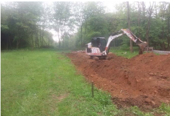
Figure 10 e 11. Lo scavo ed il modellamento dello stagno. Posa di coperte usate (recuperate gratis grazie a un annuncio su Facebook) per proteggere la posa successiva del telo impermeabile (foto A.Longo).
