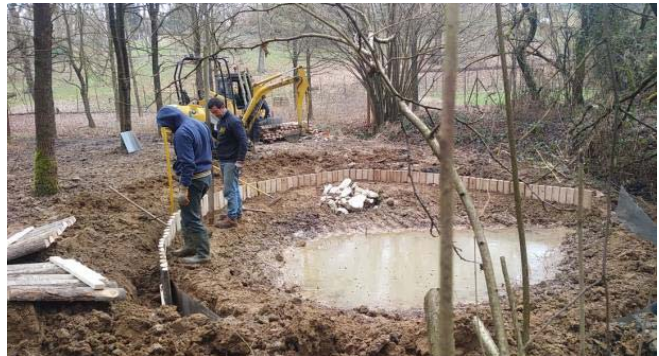
Figura 18. Un esempio di perimetrazione di sicurezza anti-gamberi nel sito individuato per il restocking di Triturus carnifex in un’area particolarmente infestata da questo predatore alloctono, sia in questa località del PLIS della Collina di San Colombano che in tutti gli altri Siti. Il materiale utilizzato in questo caso è il policarbonato trasparente, tagliato in lastre di 1 metro e sorretto da robusti paletti.
