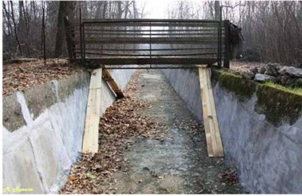
Figura 12. L'alveo artificiale del Canale "Villoresi" nel periodo invernale può costituire una trappola per la piccola fauna migrante tra le diverse aree circostanti della Riserva. In questo caso, per favorirne l'uscita, sono state posizionate passerelle di legno (foto A.Longo).
