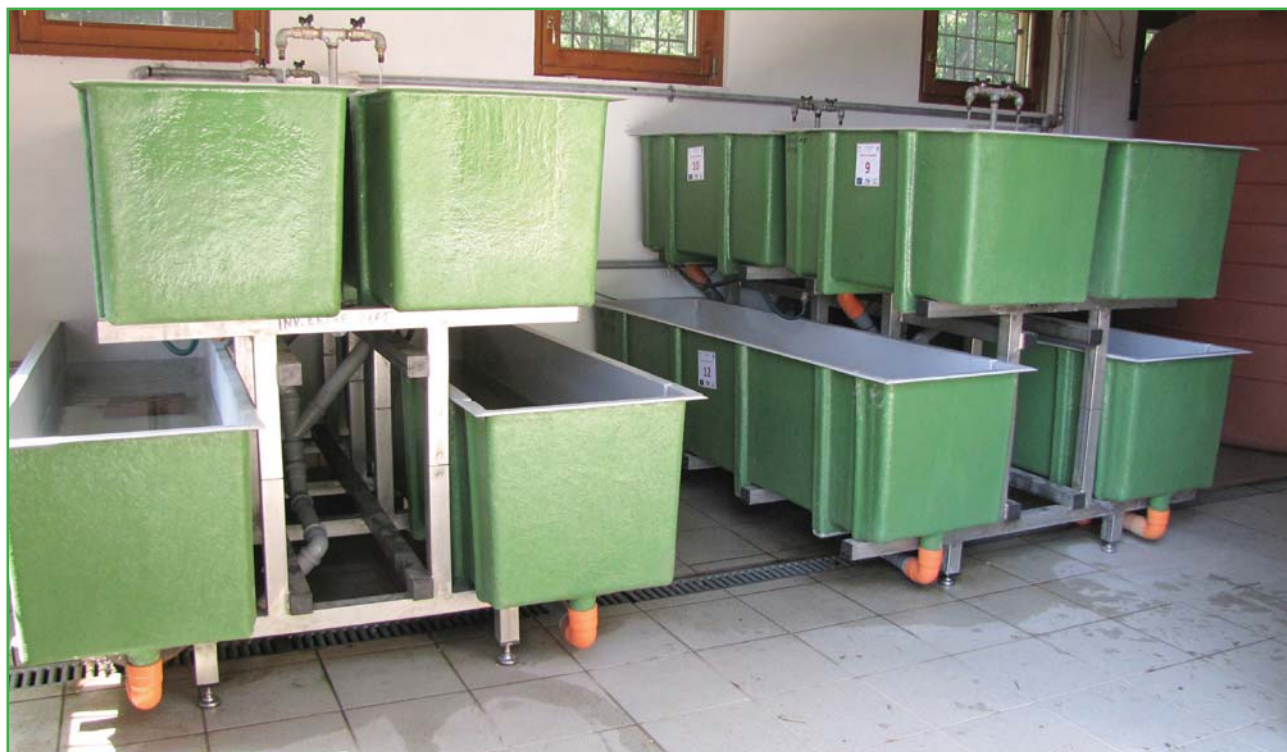
FIGURA 19. Vasche montate sul castello in acciaio.
