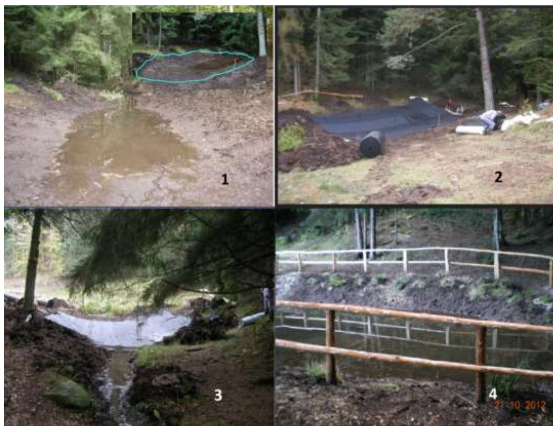
Fig. 32 Pozza per anfibi impermeabilizzata in un impluvio per meglio raccogliere le acque con impermeabilizzazione (fig 2 e 3) e recinto di protezione dal bestiame (foto 4). Azzolo, Sondrio. (Foto Vincenzo Ferri)
