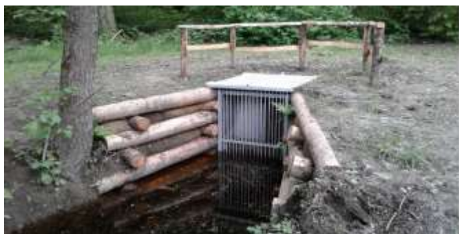
Fi.19 Strutture di regolazione dell'acqua nel progetto "Speciem per Aquam" nel Parco Lombardo Valle del Ticino (foto Bergò, Seglie, Soldato)
