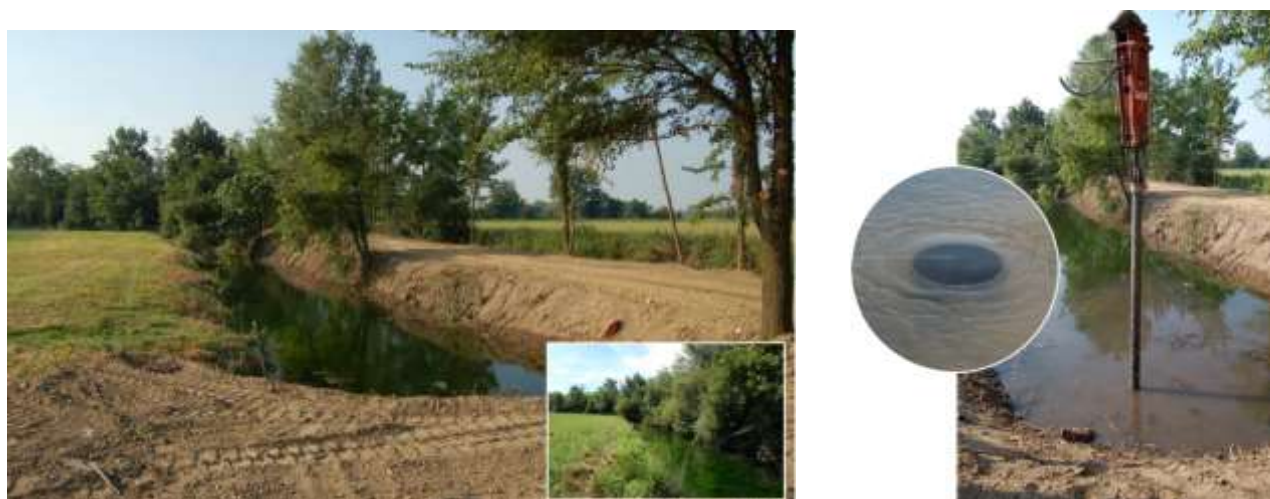
Fig.35 "Testa "ripulita e riprofilata e riposizionamento tubi emungitori del Fontanile Campociocci minore a Buccinasco (Mi) (ERSAF, 208)
