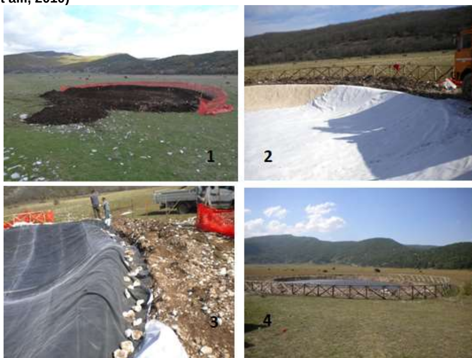
Fig.31 Stagno realizzato ex novo a valle di abbeveratoio impermeabilizzato (figg.2 e 3) e recinto per evitare l’abbeverata degli animali allo stato brado che possono utilizzare l’abbeveratoio Progetto Batracofauna. Parco del Sirente (Aq) (Foto Vincenzo Ferri)
