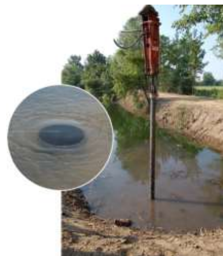
“Testa “ripulita e riprofilata e riposizionamento tubi emungitori del Fontanile Campociocci minore a Buccinasco (Mi) (ERSAF, 208)
