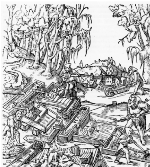
Primitiva laveria gravimetrica (De Re Metallica di G. Agricola 1494-1555) (FURIA, 2000, p. 20).
