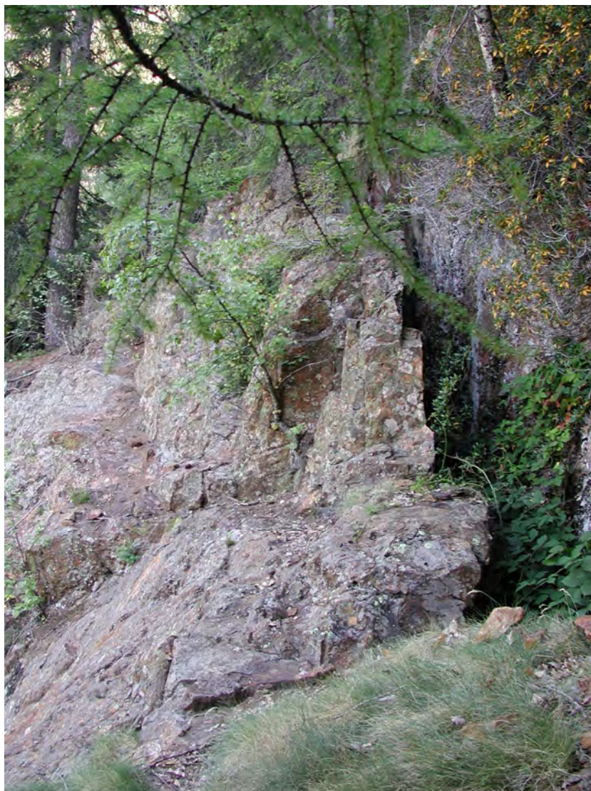
Figura 6 – Profonde fessure verticali lungo il versante destro della valle del Brembo di Carona (in prossimità di Pusdosso).
