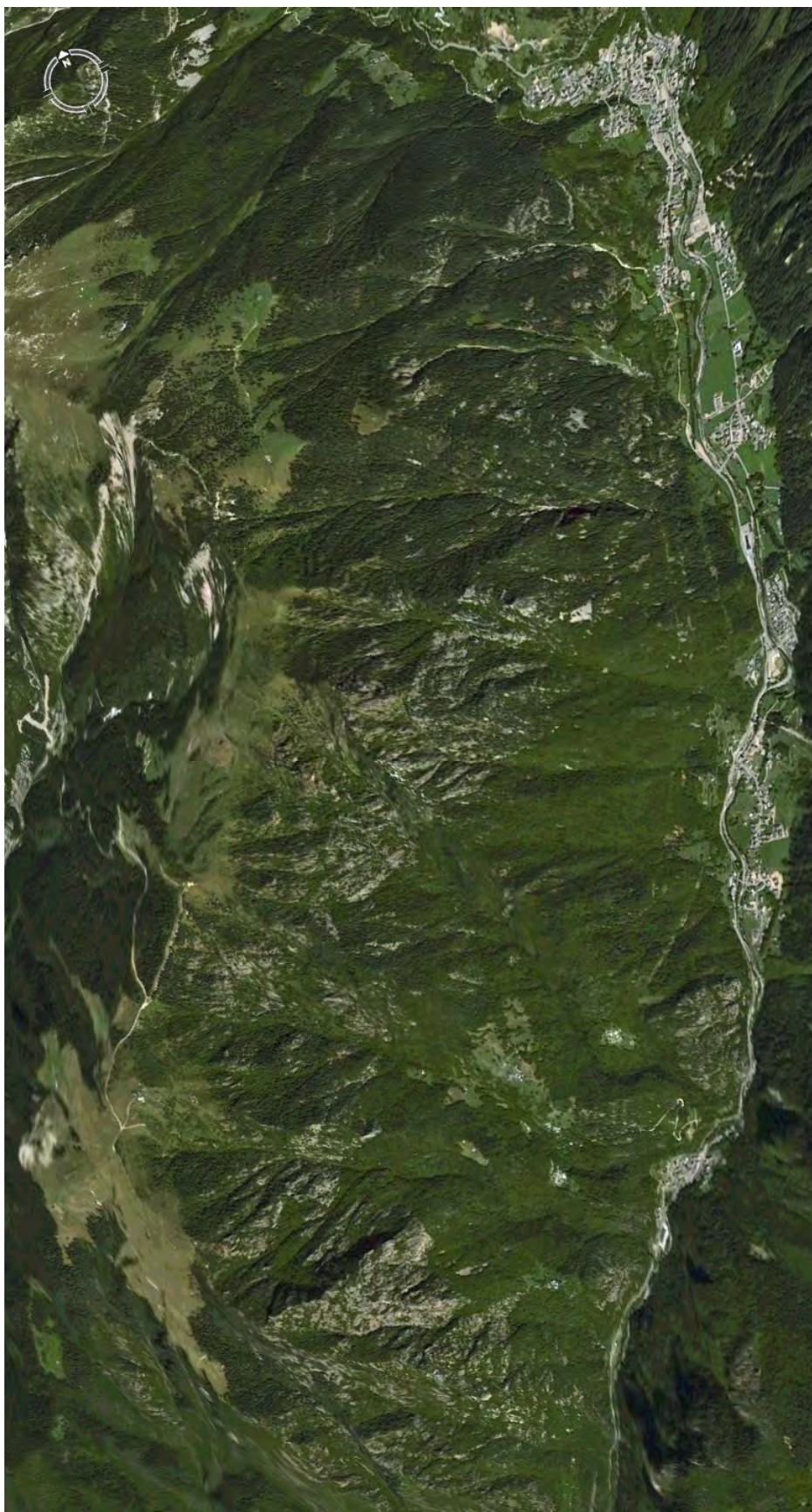
Veduta del versante occidentale della Val di Fondra. A fondovalle si riconoscono gli insediamenti di Fondra, Trabuchello e Branzi (Immagine tratta da Google)
