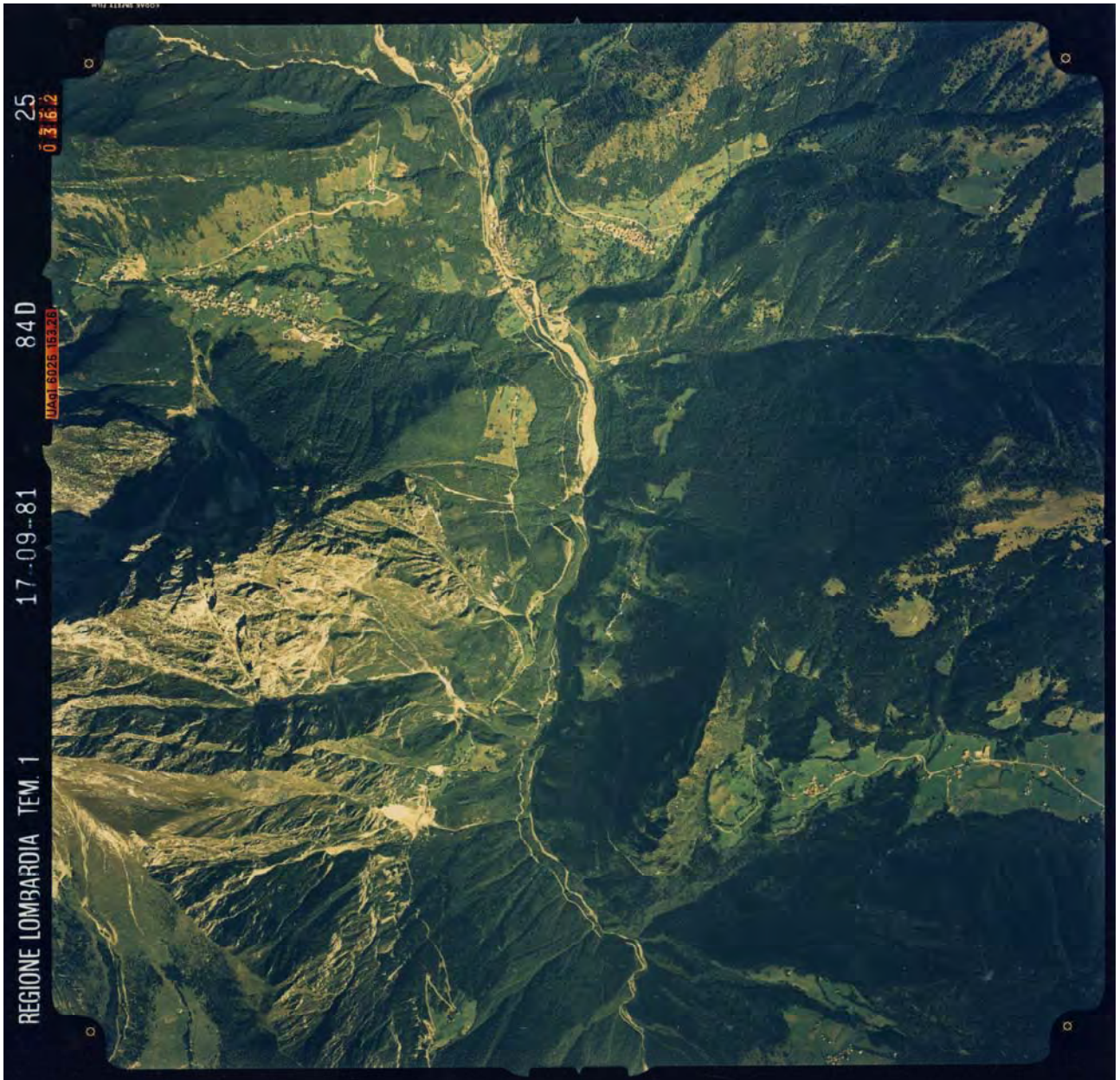
La porzione sud della Valle di Scalve, nella zona di Azzone e della "Via Mala".
