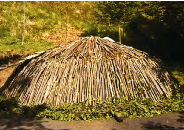
La costruzione del poiàt.
