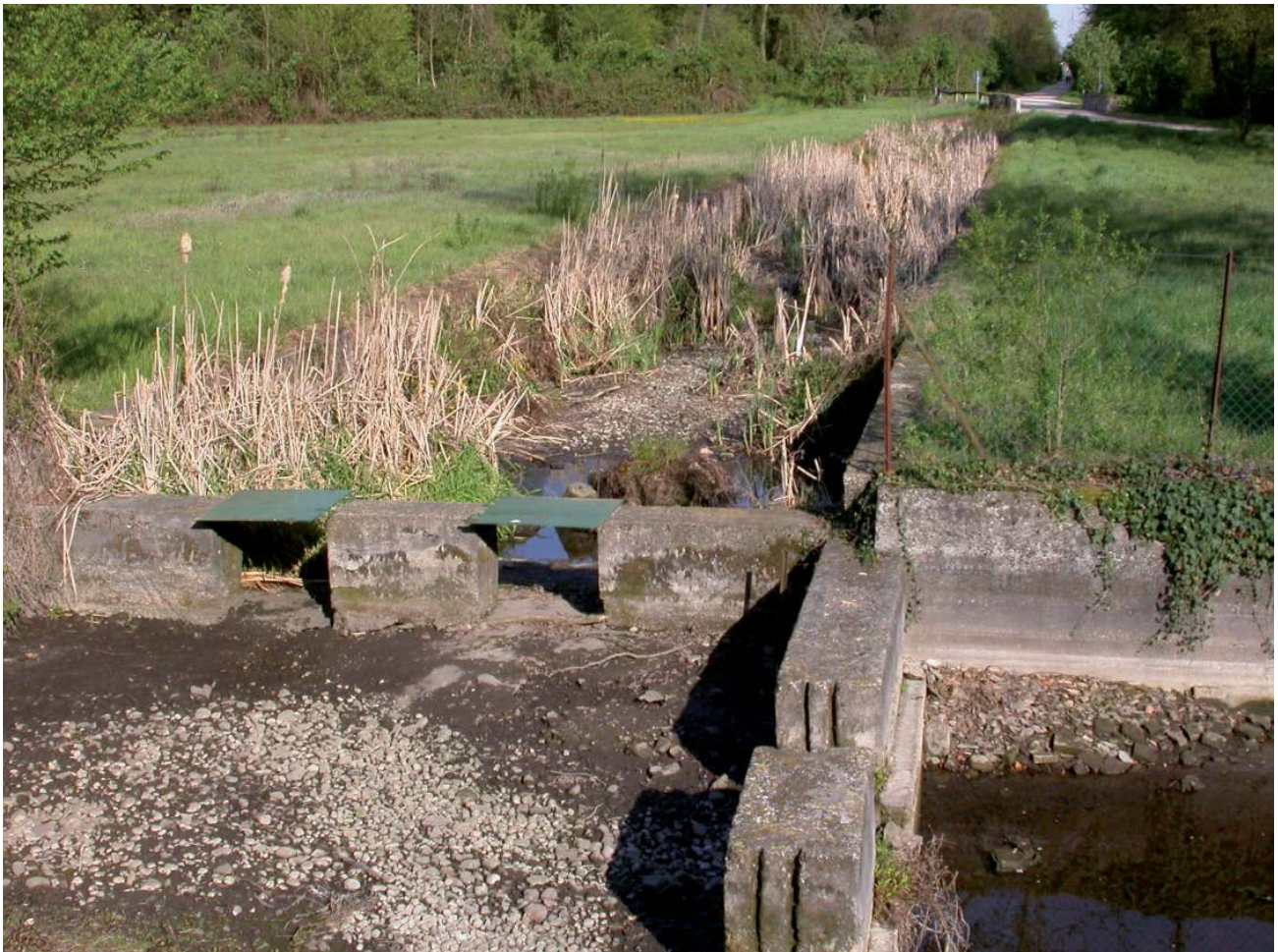
Rio Begotta in uscita dal fossato della Palazzina Gonzaga (foto Archivio CNBF).
