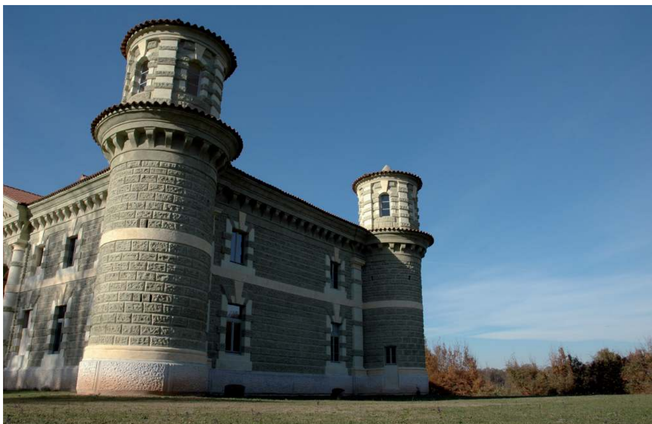
Veduta della Palazzina (foto A. Campanaro).
