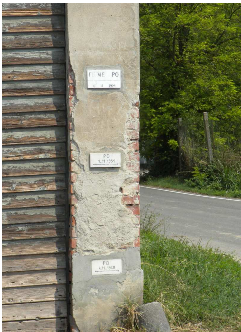
Figura 2.3 – Livelli delle piene storiche del Fiume Po nel comune di Arena Po.
