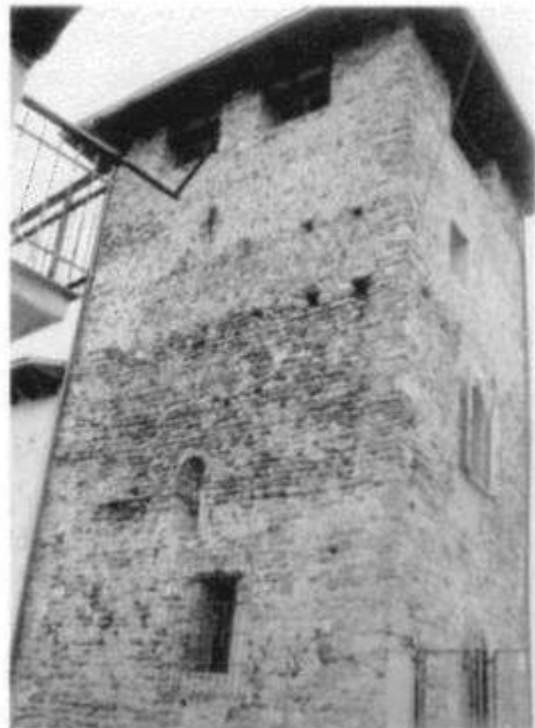
76. Vizzola Ticino, torre del castrum tardoantico ristrutturata in via Mazzini 13
