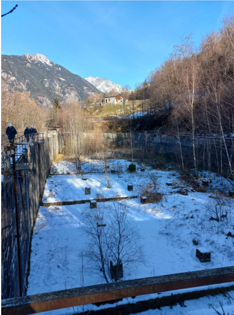
Ex vasca di carico
