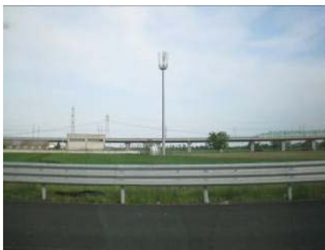
Fig 113. Autostrada l'orino – Milano. L'antenna installata in campo aperto è fortemente visibile anche da lunga distanza. Le antenne isolate devono essere programmate, se possibile, in zone in ombra, su sfondi strutturati. Sullo sfondo tralicci di elettrodotti.
