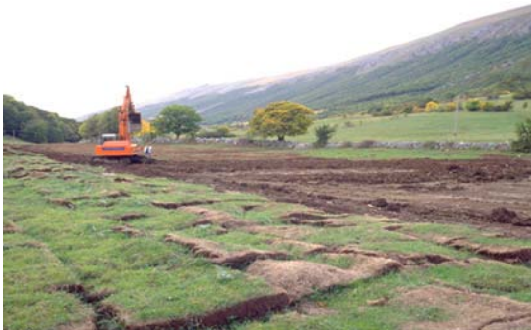
Fig 93. Gli impatti dovuti al passaggio delle condotte in territorio agricolo sono, generalmente temporanei e tuttavia non trascurabili in quanto comportano innanzitutto la perdita delle colture esistenti che dovranno opportunamente essere ripristinate. In particolare i terreni agricoli attraversati e interessati da colture a ciclo annuale dovranno il prima possibile essere posti nella condizione per la ripresa delle originarie capacità produttive ( www.snamretgas.it ).
