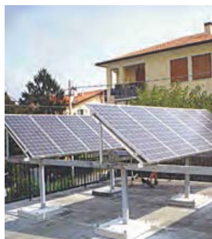
Fig 65. Nel caso di installazione su tetto piano occorre prevedere che l'altezza dei moduli fotovoltaici misurata da terra fino all'asse mediano degli assi non superi l'altezza dell'eventuale cornicione o balaustra. (GSE, "Guida agli interventi validi ai fini del riconoscimento dell'integrazione architettonica del fotovoltaico").
