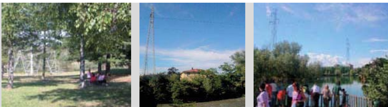
Fig 23. Esempi di cattive localizzazioni di tralicci di alta tensione: un'area verde di fruizione, un centro abitato, un laghetto.
