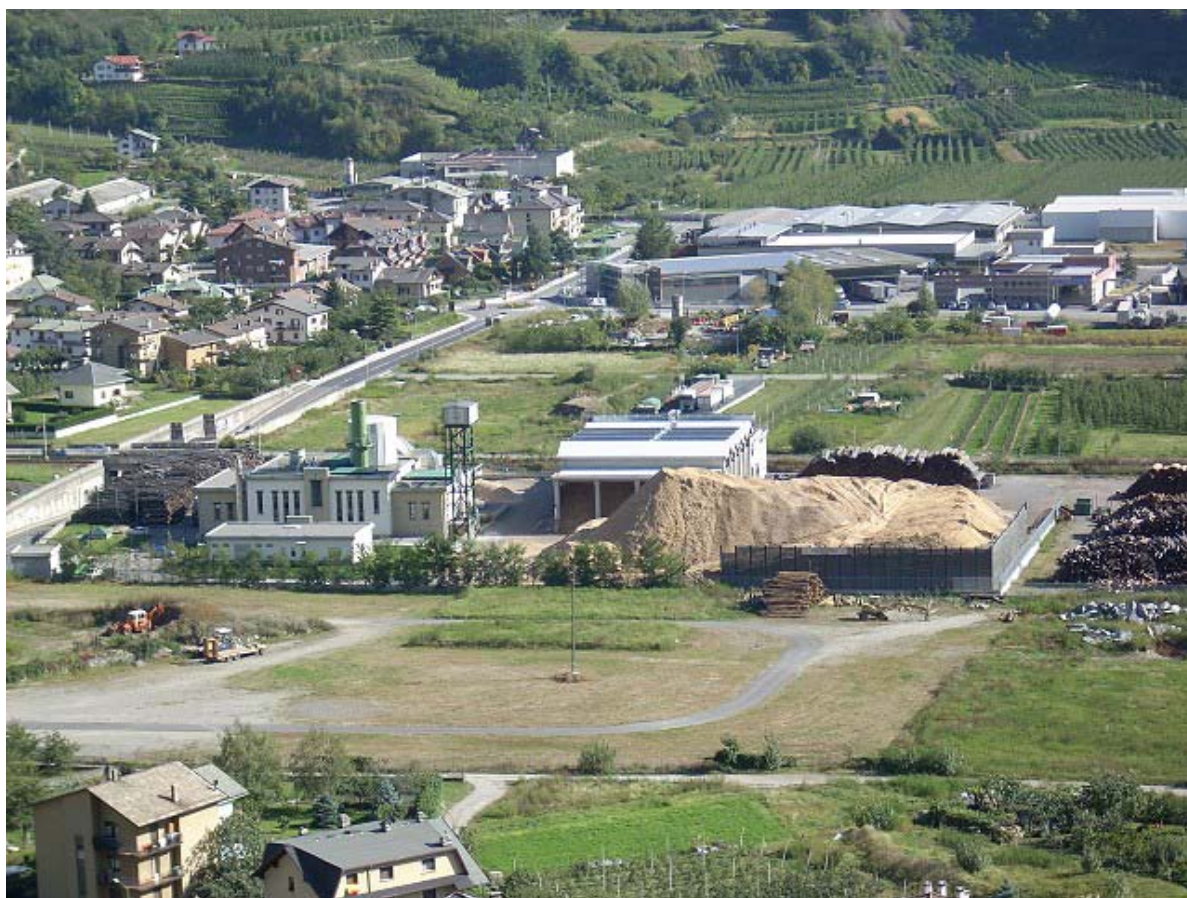
Fig 82. Scelte di ubicazione (Lombardia verde, Aprile 2007): Centrale di teleriscaldamento a Tirano alimentata a biomassa; l'impianto ha trovato sede nella zona industriale della città trovando assonanza con gli edifici già presenti.
