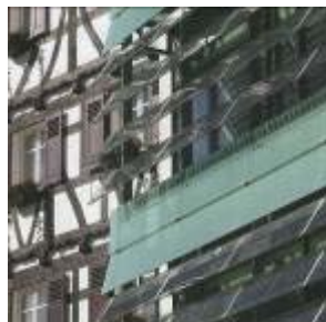
Fig 75. Edificio Zoller-alb-Kurier, Monaco di Baviera. La facciata di rottura rispetto all'edificio tradizionale non presenta soluzioni di continuità rispetto alla facciata moderna limitrofa. La discromia poteva essere evitata scegliendo un colore del vetro più adeguato rispetto al fronte strada.(BIPV)
