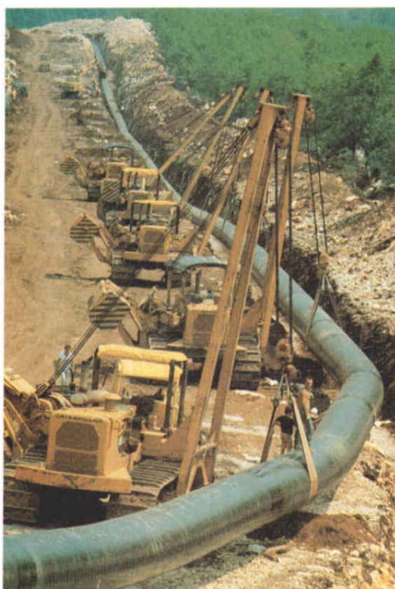
Fig 92. La posa di una condotta interrata comporta evidenti impatti dovuti alle operazioni di scasso e scavo. E' importante già in fase progettuale pianificare le operazioni di ripristino del soprassuolo evitando, comunque, l'attraversamento di zone particolarmente sensibili (www.arpa.emr.it)
