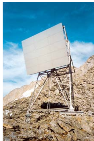
Fig 100. Ripetitore passivo di microonde. (www.Calzavara.it)
