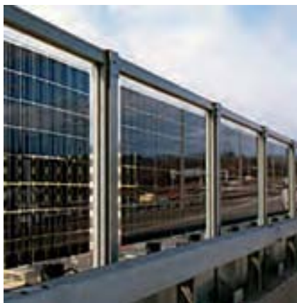
Fig 61. Lungo le barriere acustiche è possibile prevedere una sostituzione totale o parziale dei pannelli fonoassorbenti con moduli fotovoltaici. L'esposizione dei moduli fotovoltaici dovrà risultare congruente con la funzionalità tecnica di produrre energia e di isolare acusticamente. Dovrà essere dato ai moduli il corretto orientamento ed evitare che siano montati nelle parti della barriera più soggette ad ombreggiamento, deterioramento o rottura. (GSE, "Guida agli interventi validi ai fini del riconoscimento dell'integrazione architettonica del fotovoltaico".)
