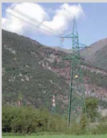
Fig 22. L'aliccio di linea ad alta tensione. Si noti come aumenta la visibilità nel caso in cui la parte terminale sia colorata a fasce bianche e rosse per renderli maggiormente visibili ai velivoli.
