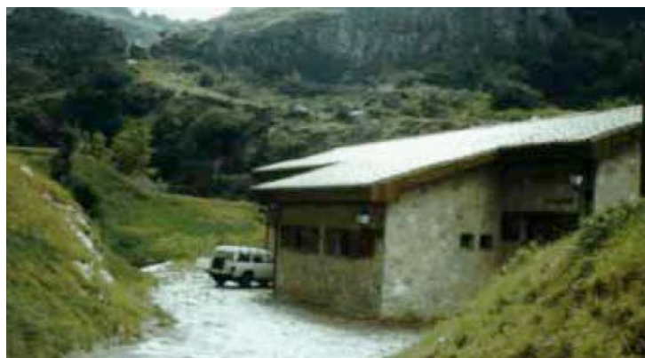
Fig 36. L' impianto di Cordinanes nel Picos de Europa (Spagna) (ESHA, Guida all'idroelettrico minore, 1998): diversi sono gli accorgimenti adottati per una mimetizzazione delle diverse parti dell'impianto nel paesaggio; La centrale ha la stessa tipologia delle abitazioni che punteggiano i versanti. I muri in blocchi di calcare, il tetto con vecchie tegole, le pesanti finestre in legno non danno evidenza della sua vocazione industriale. Oltre a ciò, la centrale è interrata per due terzi della sua altezza contribuendo così alla diminuzione dell'impatto visivo. Per mascherare le opere connesse con il canale di restituzione, sopra di esso è stata fatta una cascata artificiale. La condotta forzata corre in trincea in parte scavata nella roccia (e perciò riempita con calcestruzzo pigmentato ad essa simile), in parte nel terreno successivamente coperto dalla vegetazione.
