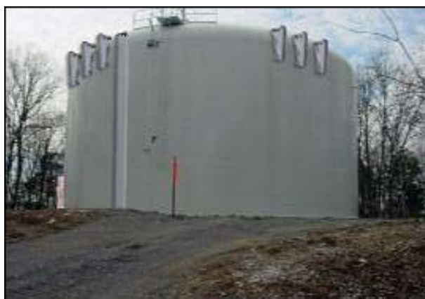
Fig 110. Criteri di posizionamento (Telecommunication Facility Guidelines, Information Bulletin 536, City of San Diego, 2008): le linee guida della città di San Diego prescrivono che le installazioni su torri dell'acqua debbano prevedere schemi simmetrici rispettosi delle forme del supporto.
