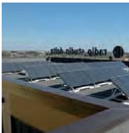
Fig 65. Nel caso di installazione su tetto piano occorre prevedere che l'altezza dei moduli fotovoltaici misurata da terra fino all'asse mediano degli assi non superi l'altezza dell'eventuale cornicione o balaustra. (GSE, "Guida agli interventi validi ai fini del riconoscimento dell'integrazione architettonica del fotovoltaico").
