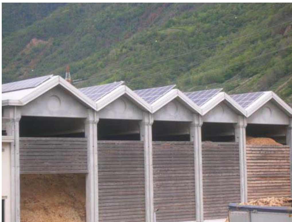
Fig 87. Deposito del cippato della centrale di teleriscaldamento a Tirano. Sul suo tetto è stato realizzato un impianto fotovoltaico.
