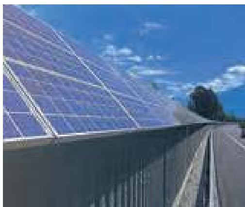
Fig 61. Lungo le barriere acustiche è possibile prevedere una sostituzione totale o parziale dei pannelli fonoassorbenti con moduli fotovoltaici. L'esposizione dei moduli fotovoltaici dovrà risultare congruente con la funzionalità tecnica di produrre energia e di isolare acusticamente. Dovrà essere dato ai moduli il corretto orientamento ed evitare che siano montati nelle parti della barriera più soggette ad ombreggiamento, deterioramento o rottura. (GSE, "Guida agli interventi validi ai fini del riconoscimento dell'integrazione architettonica del fotovoltaico".)
