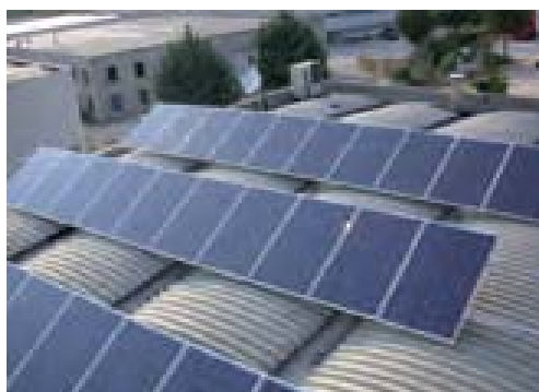
Fig 65. Nel caso di installazione su tetto piano occorre prevedere che l'altezza dei moduli fotovoltaici misurata da terra fino all'asse mediano degli assi non superi l'altezza dell'eventuale cornicione o balaustra. (GSE, "Guida agli interventi validi ai fini del riconoscimento dell'integrazione architettonica del fotovoltaico").
