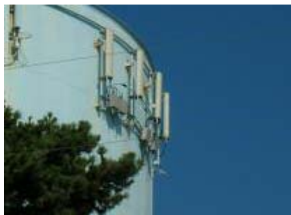
Fig 110. Criteri di posizionamento (Telecommunication Facility Guidelines, Information Bulletin 536, City of San Diego, 2008): le linee guida della città di San Diego prescrivono che le installazioni su torri dell'acqua debbano prevedere schemi simmetrici rispettosi delle forme del supporto.
