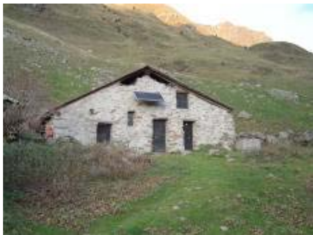
Fig 60. Alpeggio in alta Val Seriana: l'installazione dei pannelli fotovoltaici è avvenuta in posizione inadeguata rispetto all'edificio. Nel caso di integrazione all'interno di edifici con caratteri costruttivi tradizionali, le installazioni dovrebbero essere posizionate sulle falde di copertura non visibili dalle visuali principali o a terra, debitamente mitigati rispetto ai percorsi di fruizione e accessibilità pubblica.
