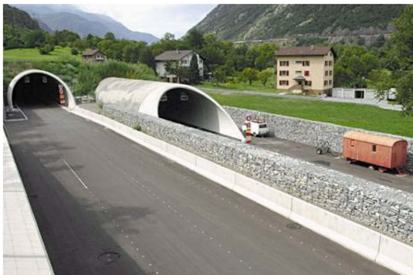
Portale di galleria e barriera antirumore - Autostrada 9 autoroute du Rhone – Svizzera
