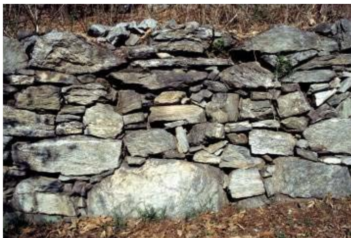
Fig. 21 - La tecnica della costruzione dei muri a secco, tramandata nei secoli, dovrebbe essere ripresa e applicata in appoggio al recupero dei sentieri pedonali.
