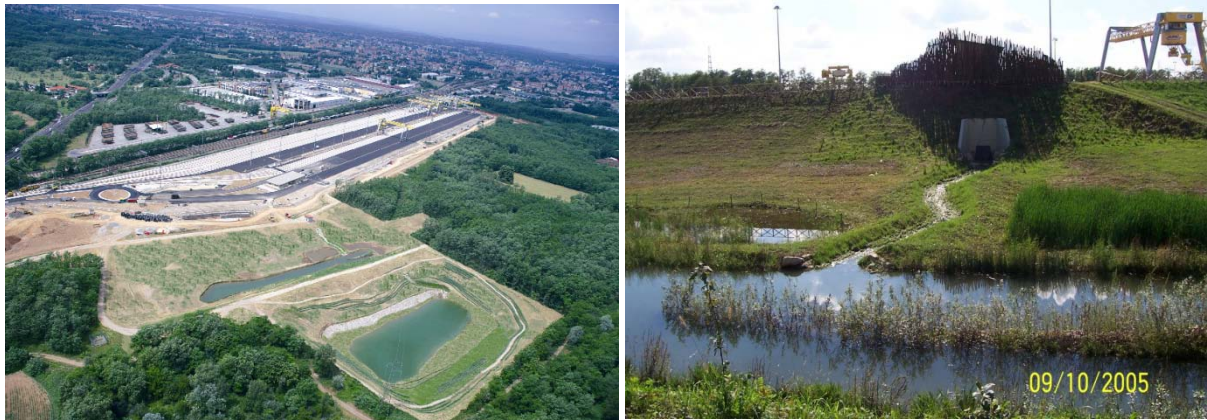
Biotopo Hupac - Realizzazione di due bacini alimentate dalle acque di seconda pioggia. Il primo bacino è disegnato in modo da fitodepurare l'acqua. Il secondo bacino, che riceve le acque per gravità dal primo, è in grado di accogliere anche parte delle acque di piena di Rile e Tenore. Interventi di compensazione per l'inserimento paesaggistico dello scalo intermodale Hupac di Gallarate nel Parco del Ticino
