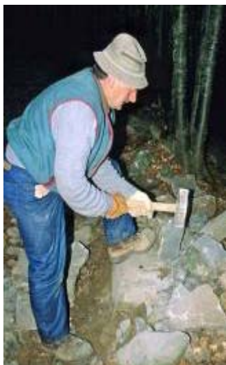
Fig. 16 - Il recupero della viabilità storica deve avvenire con l'impiego di tecniche tradizionali, purtroppo in via di sparizione.
