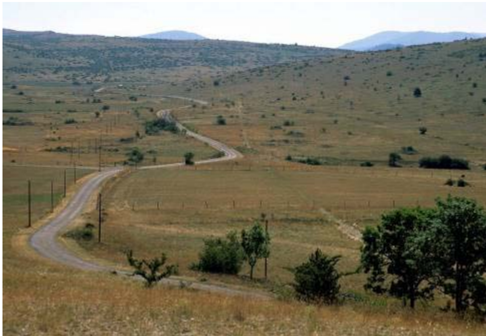
Fig. 8 - Lo studio della viabilità storica implica attente osservazioni delle modificazioni dell'assetto territoriale nel corso del tempo attraverso accurati sopralluoghi
