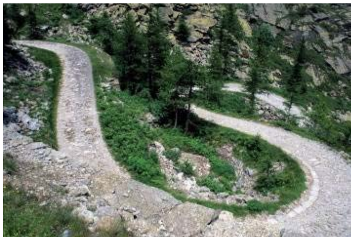
Fig. 22 - Il muro a secco oltre a essere elemento strutturale di un percorso stradale è anche un piccolo ecosistema a sé stante in grado di ospitare specie floreali e una nutrita microfauna.
