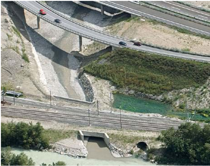
Autostrada A9 autoroute du Rhone - Svizzera Orbe-Sierre Gamsen - sottopassaggio per la macro fauna
