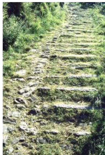
Fig. 9a - Mirabile esempio di doppia funzione all'interno di un percorso pedonale montano: la rampa selciata e incavata serviva per il disimpegno delle slitte, la gradinata per il transito pedonale. Monti di Colunno (CO).
