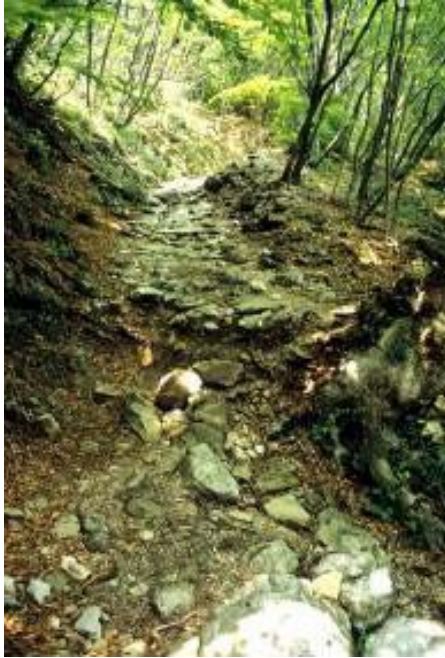
Fig. 17 - L'uso improprio dei sentieri pedonali mediante fuoristrada o moto da cross provoca danni altrettanto gravi di quelli derivati da una perduta regolazione delle acque di scorrimento. Sono queste le due cause che conducono più frequentemente al degrado e alla distruzione di consistenti tratti di sentieri storici.
