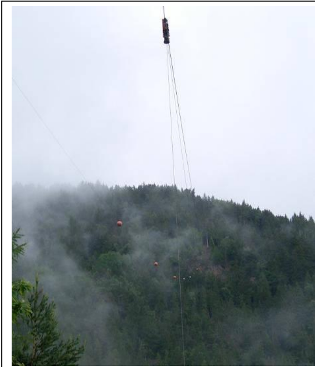
Cavo di guardia munito di palloni. Valtellina. (Foto Matteo Pozzi).
