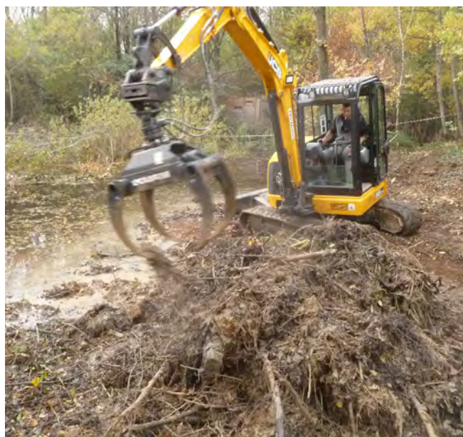
Diradamento vegetazione e modellamento sponde (foto F. Cologni)
