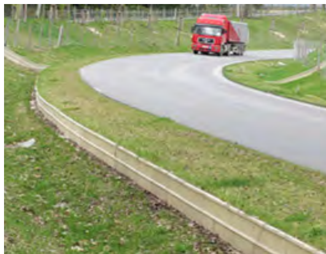
Un elemento per comporre barriere anti-scalata per piccola fauna terricola (in calcestruzzo polimerico, con superfici lisce, impermeabili, a conduzione termica minima). Nella foto l'esempio ottimale di posizionamento e sistemazione del barrieraggio anti-scalata per piccola fauna terricola. Come si vede, dal piano stradale gli individui che comunque vi siano finiti possono facilmente allontanarsi: le barriere hanno il loro culmine a raso proprio con il piano stradale ed i suoi terrapieni laterali. (Foto ACO Wildlife)
