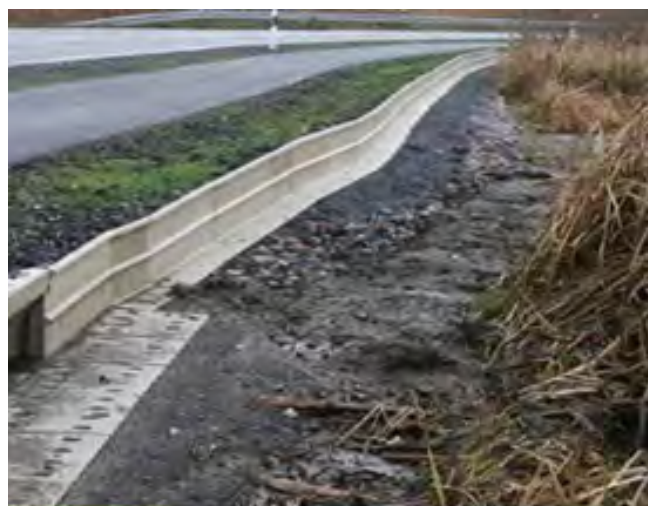
Un sistema ideale tunnel –barriere anti-scalata per ridurre o impedire il road-killing di una popolazione di anfibi durante la tras migrazione riproduttiva attraverso una strada con elevato traffico. Le pareti che compongono questa barriera (Foto 108) anti-scalata per piccola fauna terricola sono in polimero di calcestruzzo (Foto ACO Wildlife)
