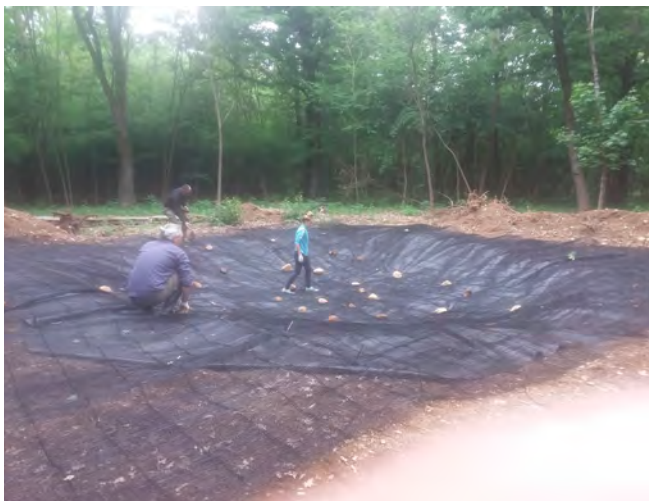
Posa del telo impermeabile e della rete plastificata per favorire la tenuta della terra, non sempre, nella realizzazione degli stagni viene inserito questo strato ma è consigliato perché favorisce la miglior distribuzione e tenuta del terreno. Posa della terra (foto A. Longo)
