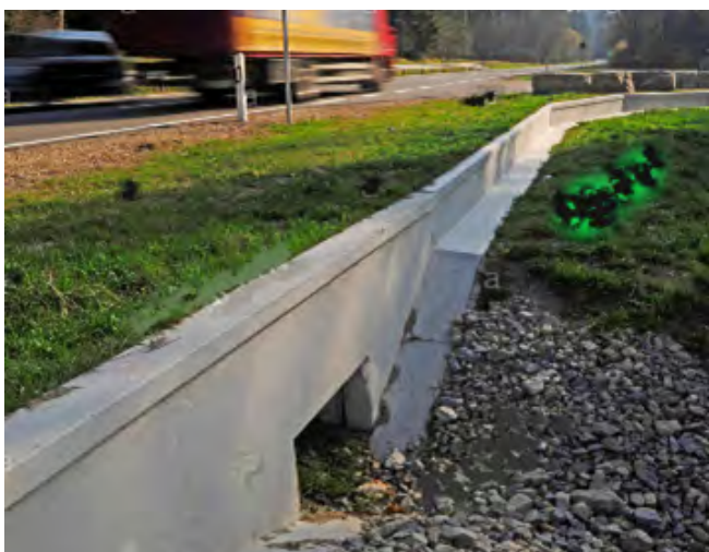
Un sistema ideale tunnel –barriere anti-scalata per ridurre o impedire il road-killing di una popolazione di anfibi durante la tras migrazione riproduttiva attraverso una strada con elevato traffico. Le pareti che compongono questa barriera (Foto 108) anti-scalata per piccola fauna terricola sono in polimero di calcestruzzo (Foto ACO Wildlife)
