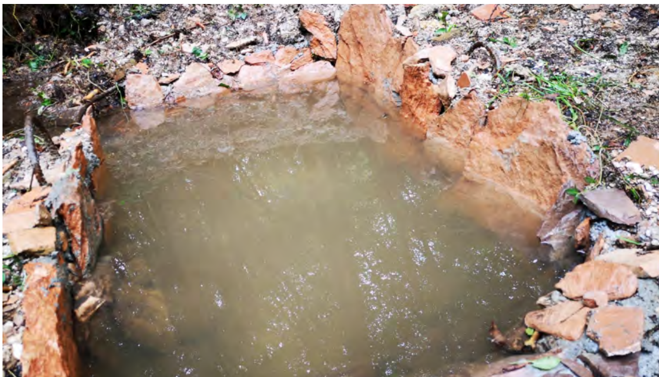
L'aspetto alla fine dei lavori di una delle tre vaschette neoformate. Base di malta cementizia su una struttura "portante" di rete metallica zincata (immersa completamente nella matrice di fondo); pietre di calcare raccolte localmente, cercando di scegliere quelle più appiattite, cementate ed avvicinate l'una all'altra più possibile. Tubo in polietene di collegamento con il ruscello a monte, su uno dei lati maggiori. (Foto E. Carturan)
