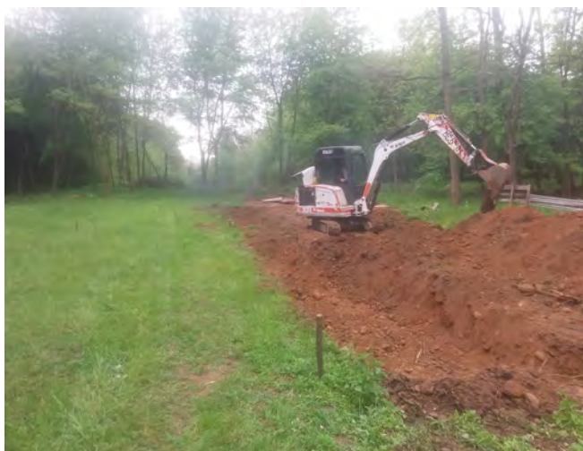
Scavo e modellamento dello stagno. Posa coperte usate (recuperate gratis grazie a un annuncio su FB) per proteggere la posa successiva del telo impermeabile (foto A. Longo)
