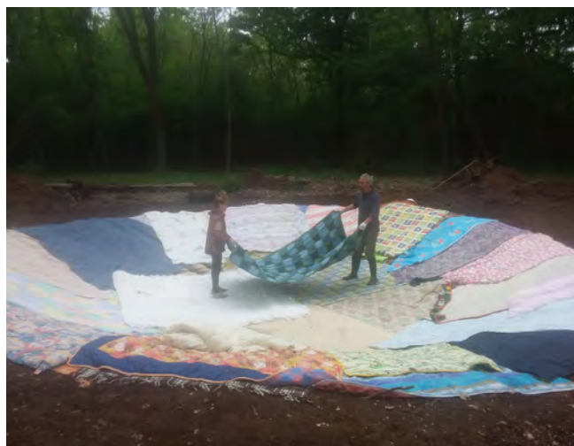
Scavo e modellamento dello stagno. Posa coperte usate (recuperate gratis grazie a un annuncio su FB) per proteggere la posa successiva del telo impermeabile (foto A. Longo)
