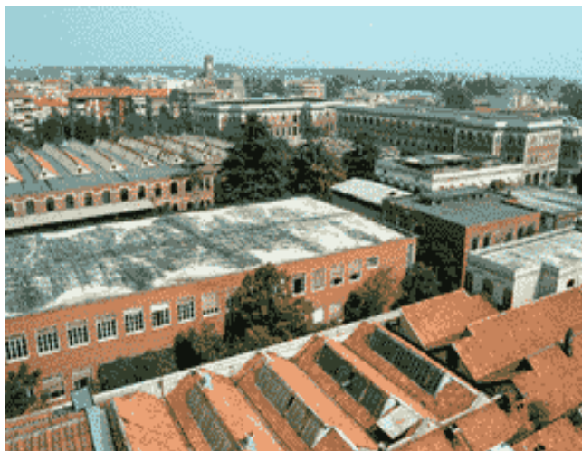
Lo stato di fatto – vista dei capannoni
