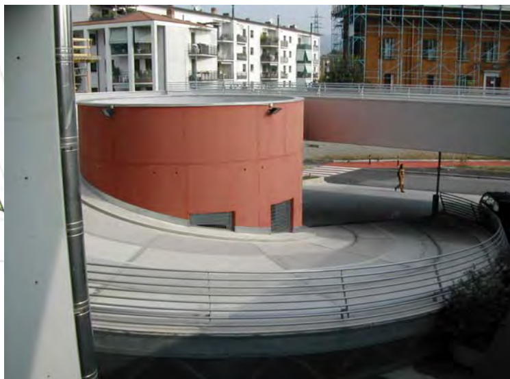
La rampa di distribuzione ai diversi livelli di parcheggio
