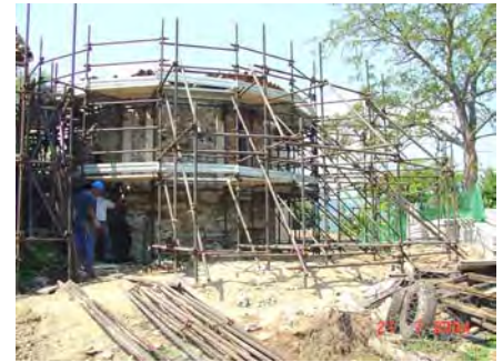
Stato di avanzamento lavori
