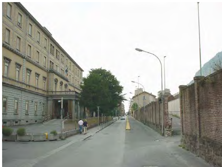
L'ingresso del vecchio Ospedale su via Ghislanzoni
