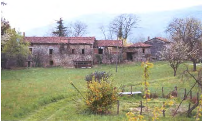
Stato di fatto – il complesso delle cascine
