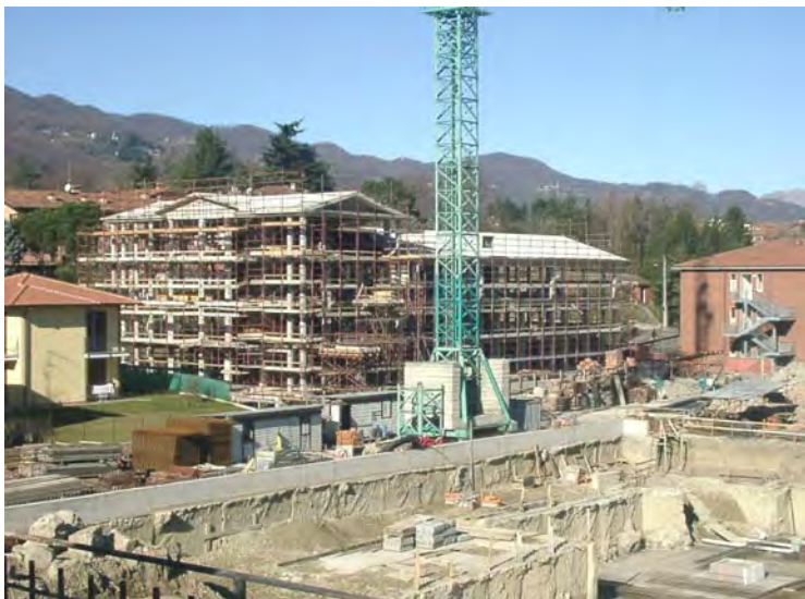
Lotto B in costruzione
