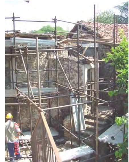
Stato di avanzamento lavori
