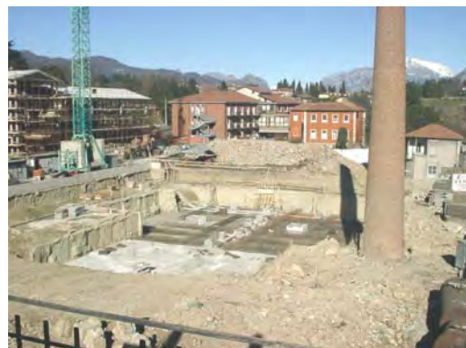
Lotto A – parte dello scavo
