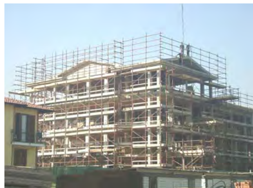
Lotto B in costruzione
