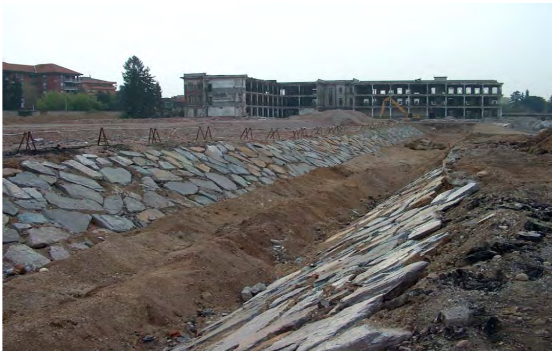
Il cantiere: realizzazione del nuovo corso d'acqua
