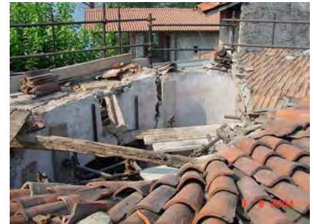
Stato di avanzamento lavori
