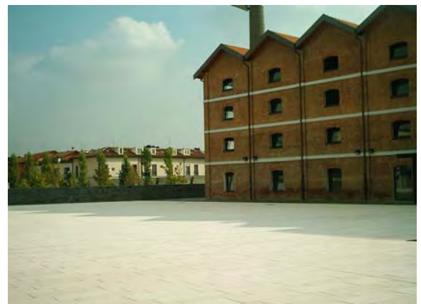
Scuola Enaip- particolare del prospetto nord dopo la ristrutturazione
