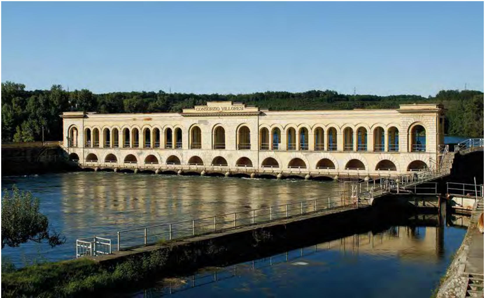
Fig. 4 Le Dighe di Panperduto
