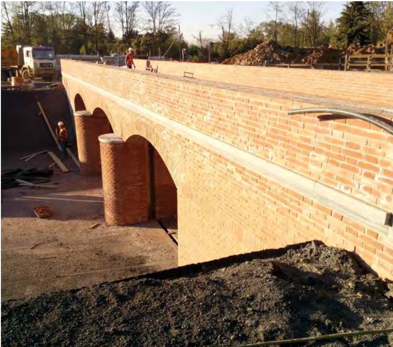
Fig. 7 Vie d’Acqua – realizzazione nuove opere di regolazione idraulica sul Canale Villorresi
