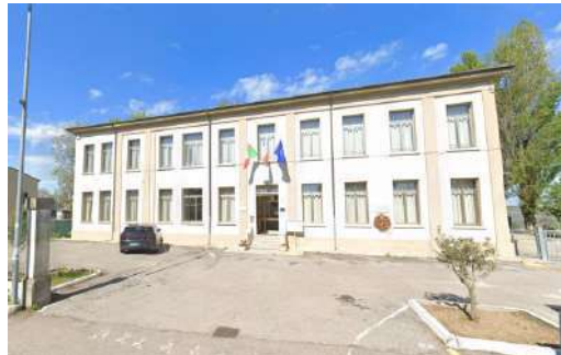
Immagine 28: l'edificio oggetto di intervento
