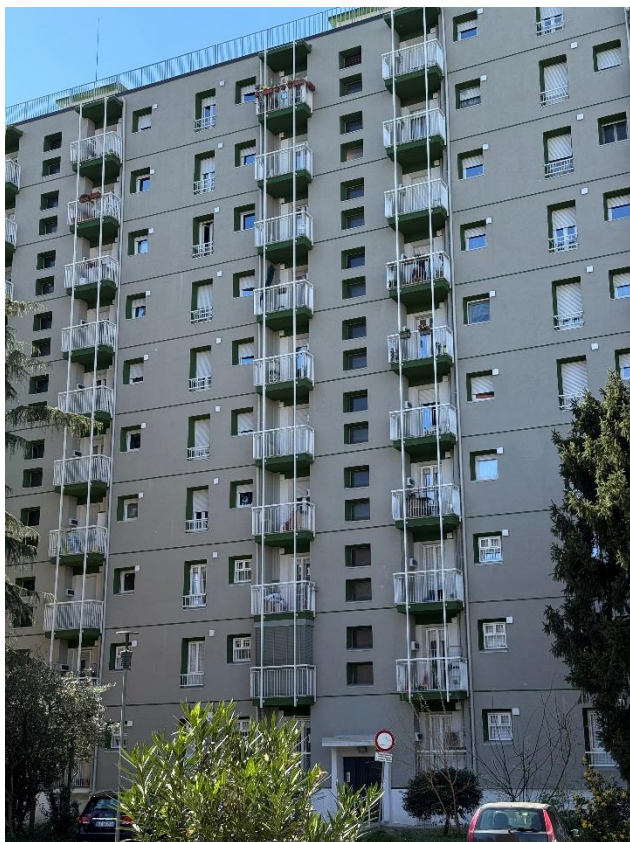
Via Baroni 150-154 (concluso)
