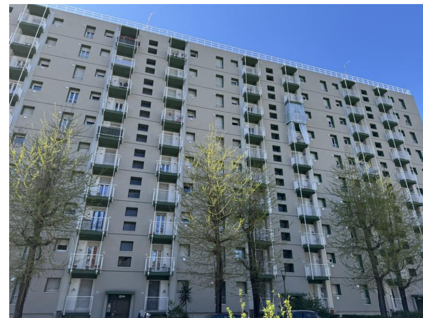
Via Baroni 166-172 (concluso)
