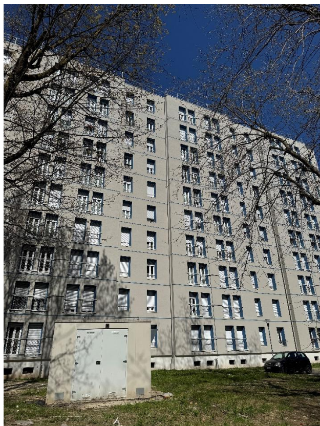
Via Baroni 200-204 (concluso)
