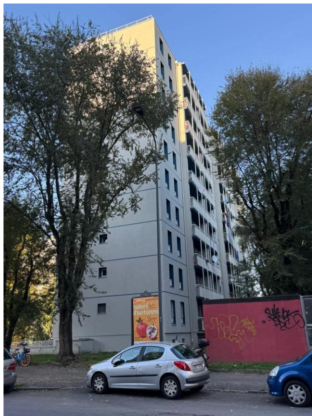
Via Saponaro 45-47-49 (concluso)
