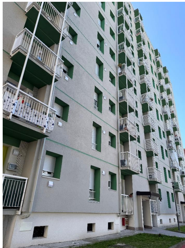
Via Baroni 206-210 (concluso)
