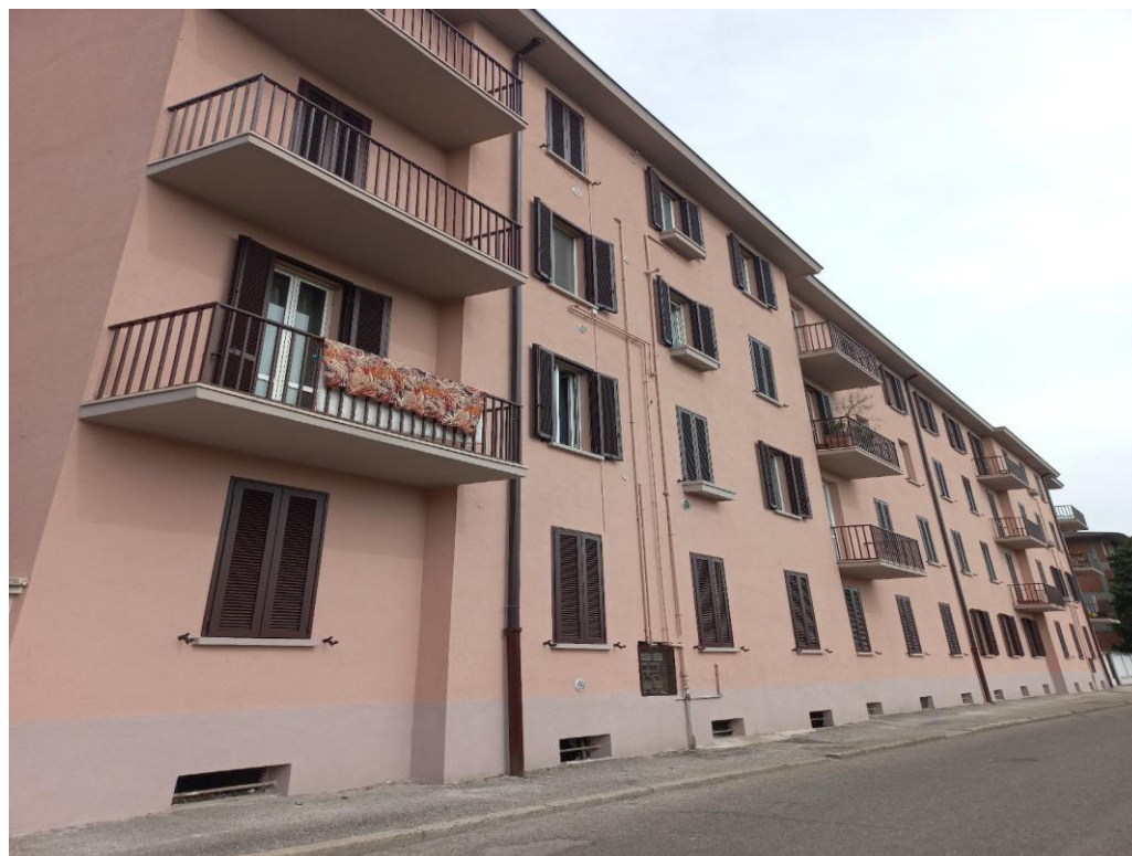
Facciata ultimata edificio E-F-G
