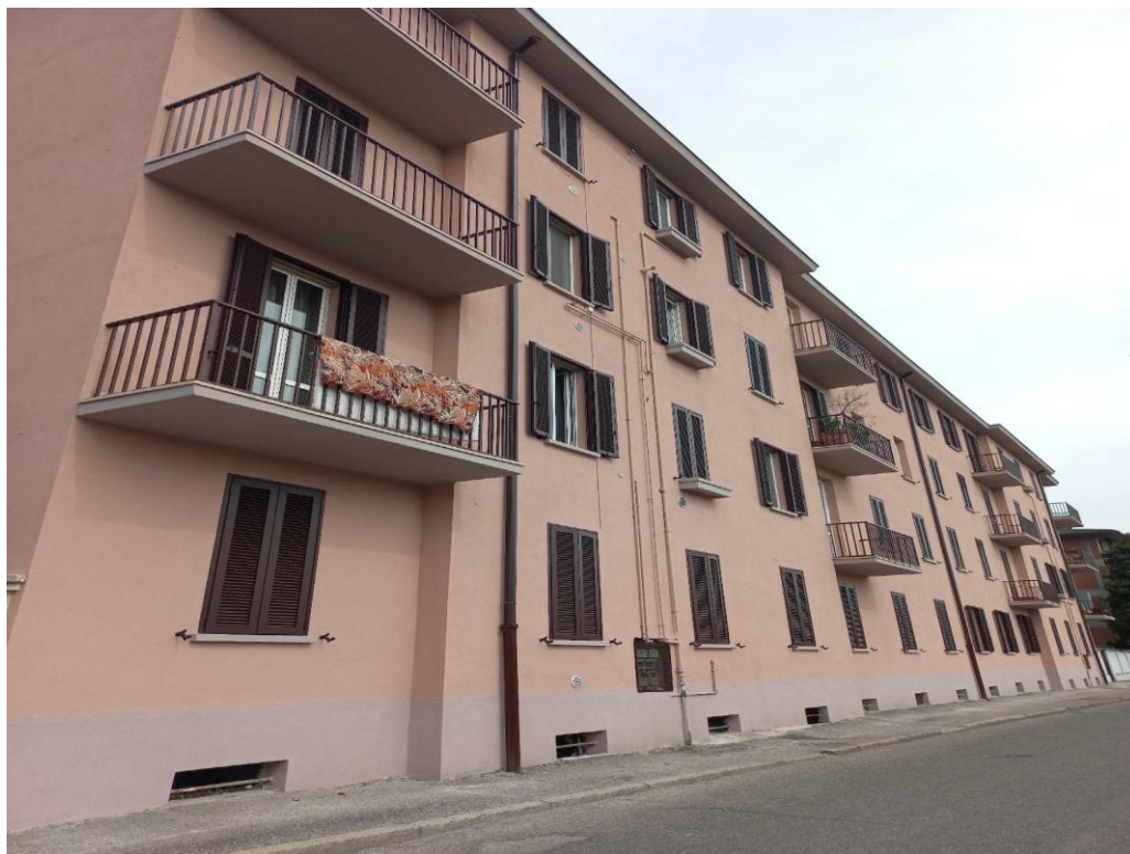
Facciata ultimata edificio E-F-G
