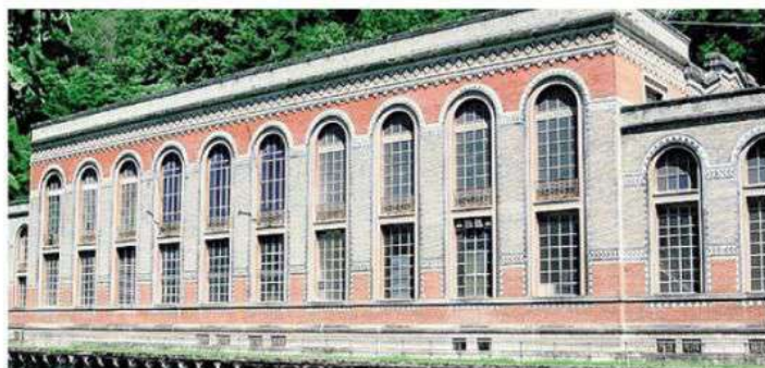
Tra gli impianti interessati figurano quelli di Lovero, Grosio, Grosotto, Stazzona e Premadio
